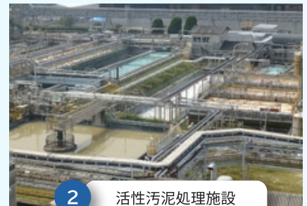
2 活性汚泥処理施設
