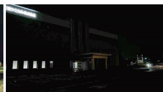
管理棟正面ライトダウン後
