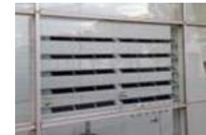
実証実験 (OPV一体型ルーバー)
