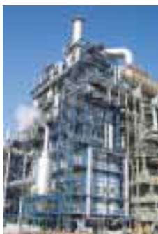
鹿島事業所エチレンプラント 最新鋭分解炉 (三菱化学(株))
