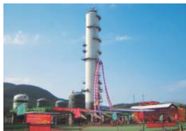
▲ 中国の寧波大樹開発区において建設中の高純度テレフタル酸製造設備 (寧波三菱化学有限公司)
