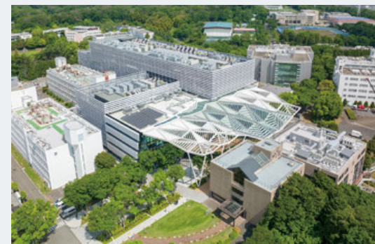
Science & Innovation Centerに新研究棟を開設
